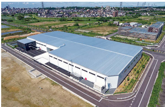
〈新本社工場全景〉
